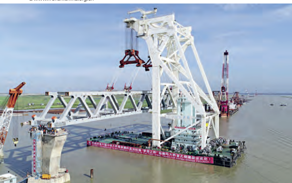
Le pont Padma en construction
