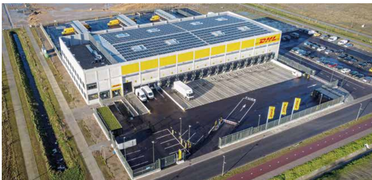
En raison de la croissance du e-commerce, la demande de bâtiments logistiques plus petits a également augmenté, de préférence à proximité des villes. Voici le centre de tri DHL Express à Blue Gate Antwerp.
