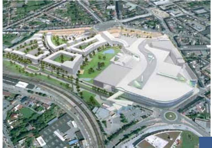
Implanté au cœur de La Louvière, le projet de rénovation urbaine «La Strada» s'étend sur 15 hectares, avec l'ambition de recréer un centre-ville par le développement d'un grand projet mixte.
