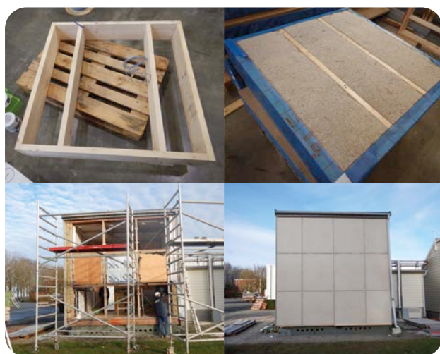
1 Réalisation du dispositif d'essai.
