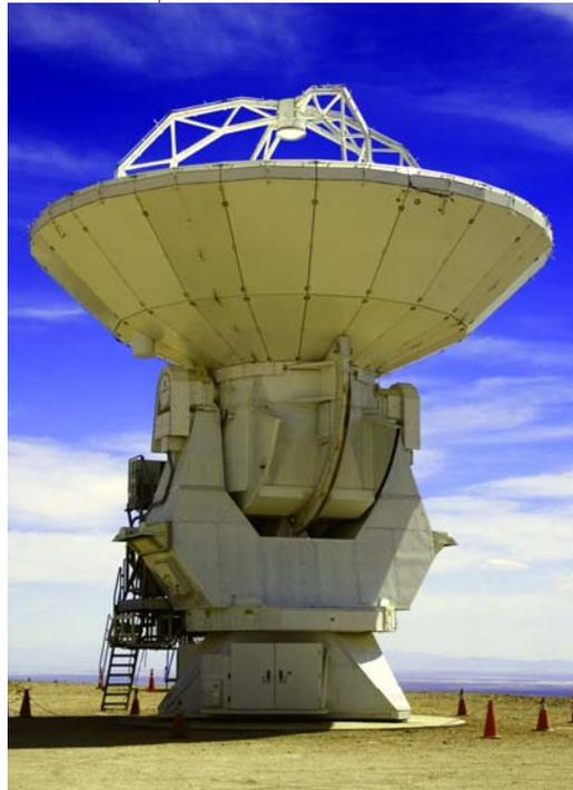
*ALMA, le nouvel observatoire européen au Chili, commence à se construire. Une première antenne de 12 m de diamètre et pesant 100 tonnes a en effet fait son apparition sur le site de Chajnantor (5 000 m d'altitude). Elle devrait bientôt rejoindre une cinquantaine d'autres antennes, qui observeront de concert le rayonnement millimétrique.*
