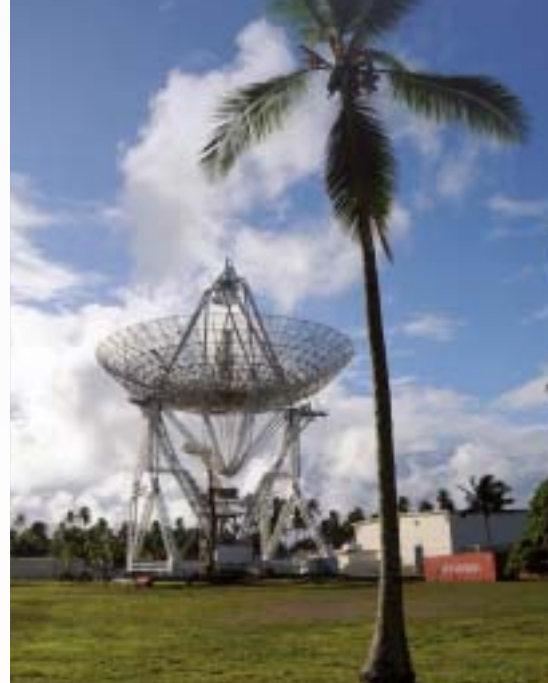
Antenne radar longue portée (ALTAIR) pour détecter les objets spatiaux aux îles Marshall
