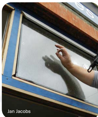
4 Placement d'un vitrage entre deux parclozes.
