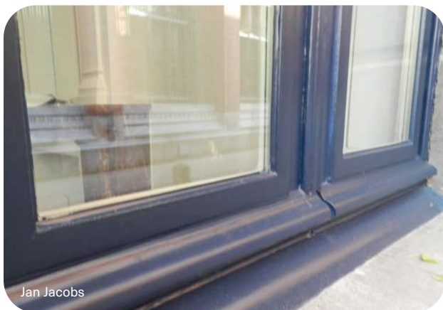
1 Double/triple vitrage dans un profilé d'adaptation.
