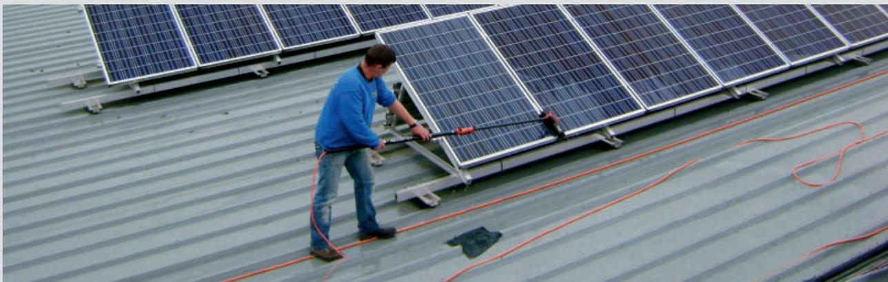
Longtemps, on a pensé que les panneaux solaires ne nécessitaient aucun entretien, le vent et la pluie suffisant à les débarrasser de certaines saletés. On sait désormais que pour conserver un rendement optimal, ces panneaux doivent faire l'objet d'un minimum d'entretien.
