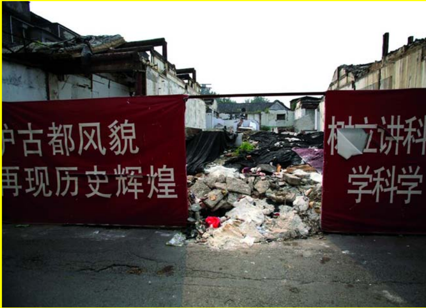
Demolition à Pékin, District de Qianmen. © Dubin
