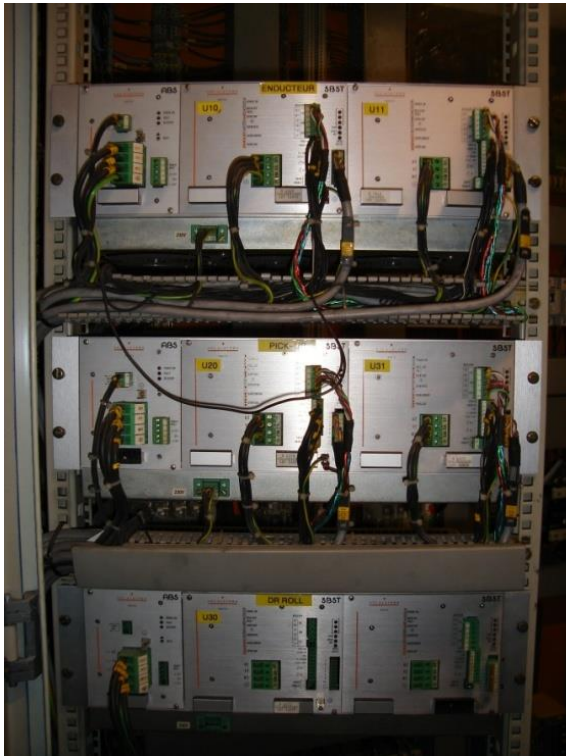
Fig. 10 : Les six anciens drives PARVEX ABS
