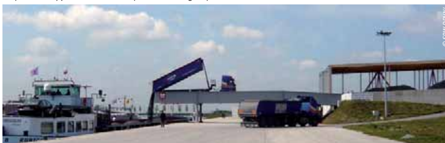
Le quai de Strépy et ses nouvelles infrastructures logistiques.
