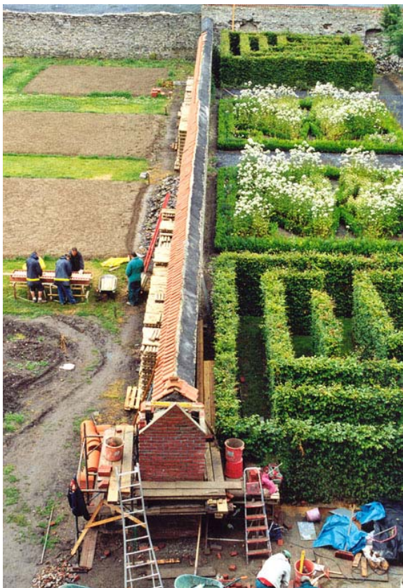
Restauration du mur qui sépare le jardin régulier du jardin nourricier
