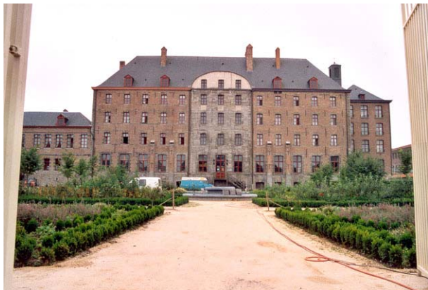
Façade arrière de l'ancien Séminaire de Choiseul. A l'avant-plan, le jardin régulier.
