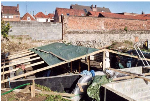
Le vivier, en chantier dès 2000.
