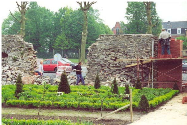
Rénovation du mur d'enceinte. Travaux de maçonnerie pour les stagiaires, côté jardin nourricier.
