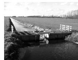
Exemple de watergang, de la taille d'un fossé, dont le profil évasé permet d'augmenter la contenance et le débit au fur et à mesure de la montée de l'eau
