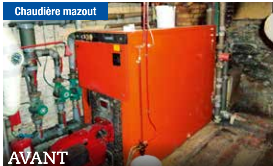
Chaudière mazout
