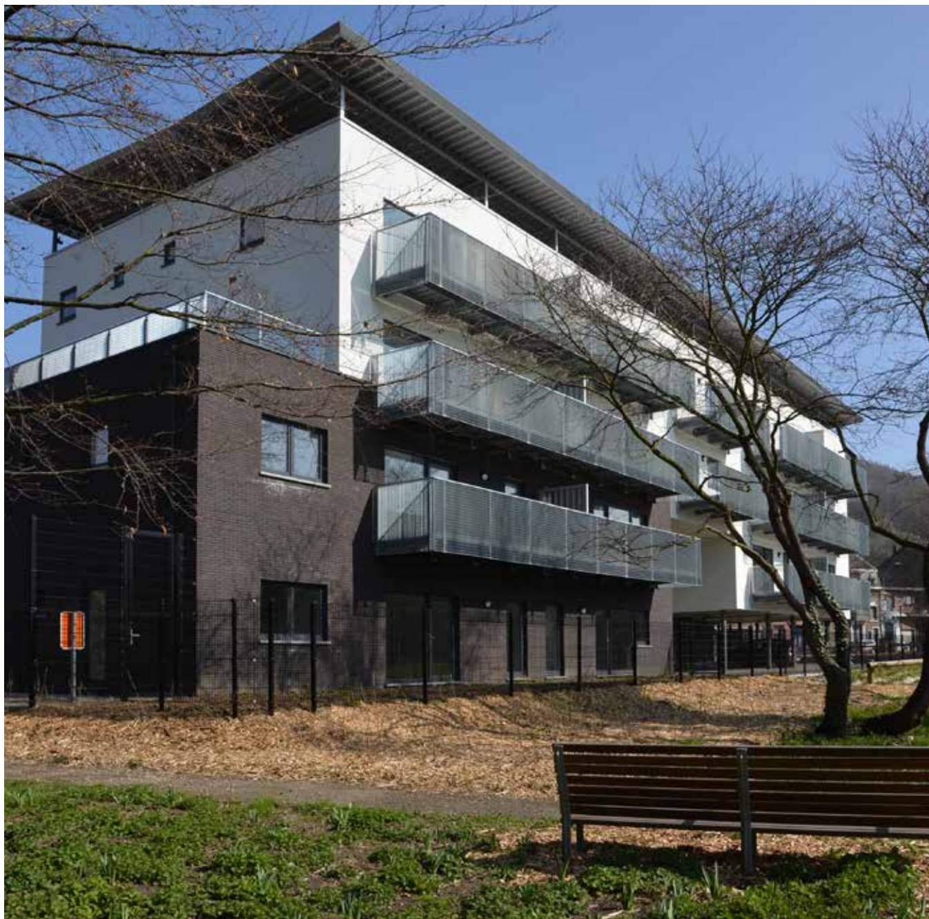
Logements publics à Liège © Fabrice DOR (SPW/DG04)
